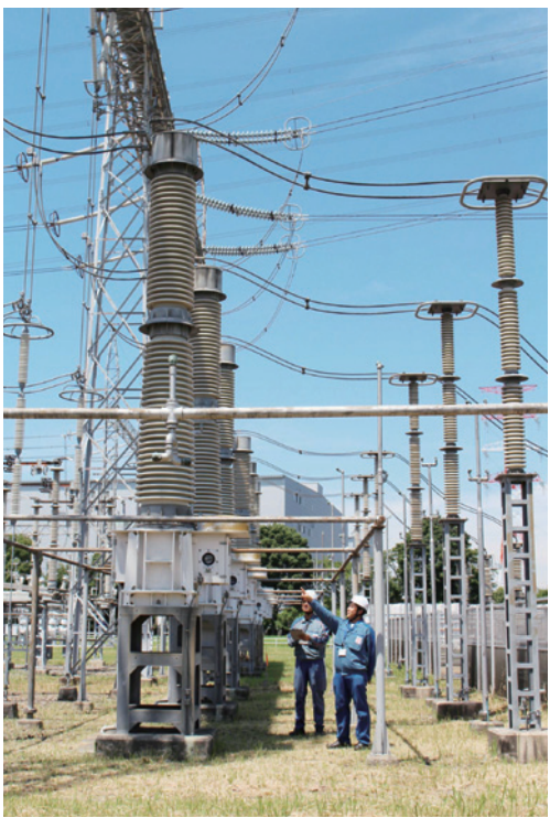
電力を送り続けるため日々の点検に万全の注意が払われる
